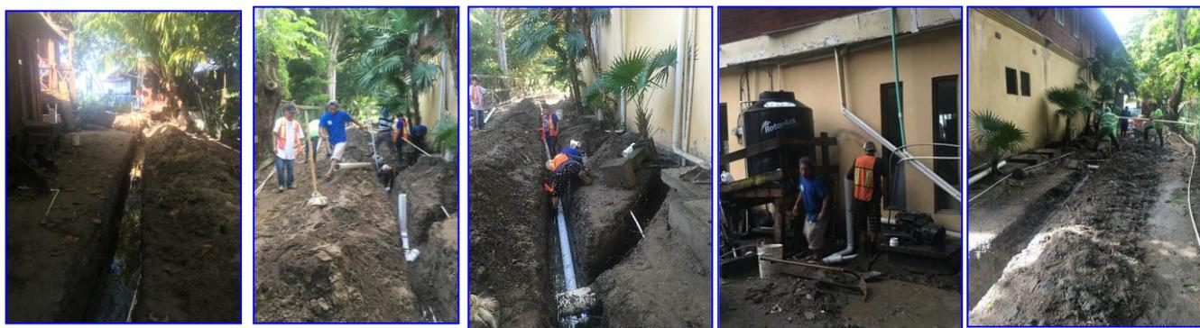
Después: Trabajos de excavación, drenando aguas e instalación de tuberías.
