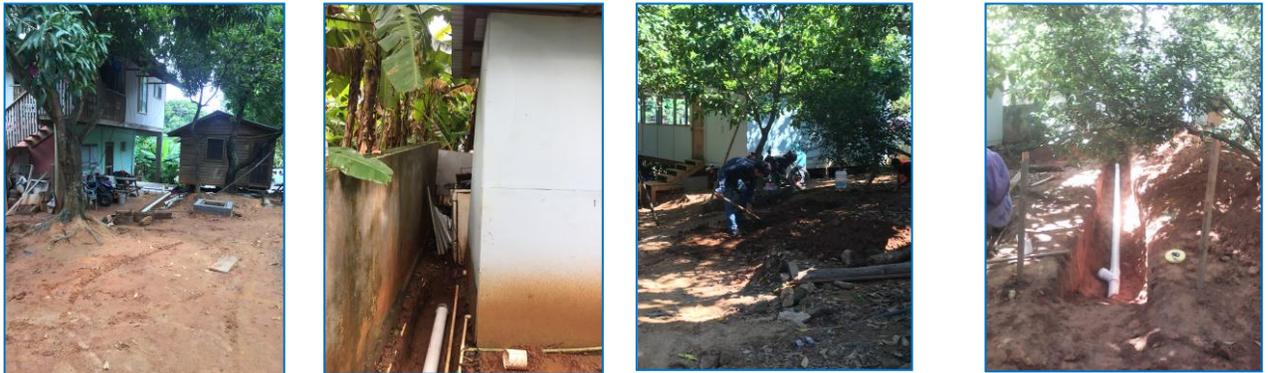
Después: Excavación, conformación, instalación de tubería, relleno con material del sitio y construcción de caja de registro.
