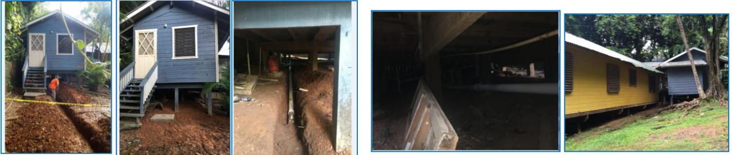
Trabajos de excavación, construcción de caja de registro, instalación de tubería tanto para conexión de sanitarios como de ducha, lavamanos y lavaplatos.
