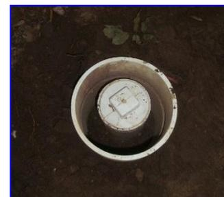
Excavación de terreno, instalación de tubería de PVC 4" línea principal y instalación de tubería PVC 2" para instalaciones de lavadora, ducha y lavamanos y lavaplatos, colocación de trampa que evita malos olores, colocación de cleanout para inspecciones futuras.
