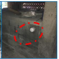
Después: trabajos de excavación en suelo tipo arrecife, instalación de tubería fijada con abrazaderas, tapón de pvc en séptico
