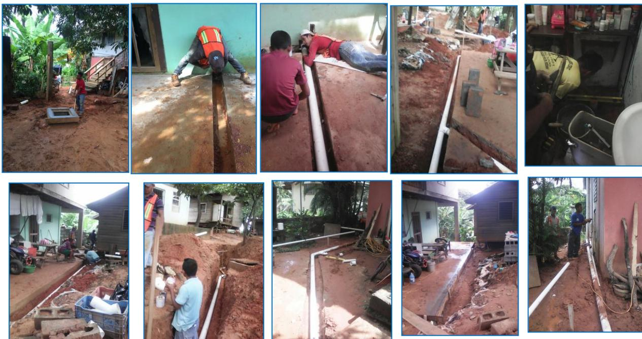
Trabajos de excavación, conformación e instalación de tuberías para conexión de sanitarios, duchas, lavamanos, lavaplatos, lavadora, construcción de caja de registro
