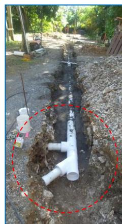
Excavación de terreno, conformación con arena, instalación de tubería de PVC 6" SDR26, se dejaron tramos cortos de líneas secundarias para conexiones futuras de lotes.
