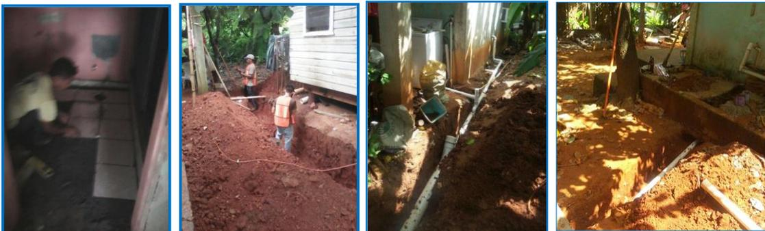
Trabajos de excavación corte de losa de concreto, levantamiento de sanitario, reparación de cerámica dañada al levantar sanitario, instalación de tubería de PVC de 4" y PVC 2"
