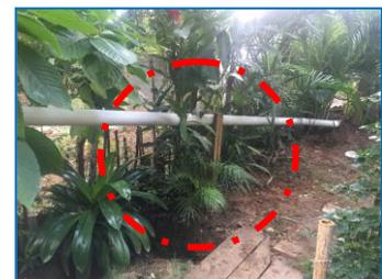
Trabajos de conexión, tubería anclada en piezas de madera a la pared de la casa, y encajuelado de columna falsa para cubrir tubería.
