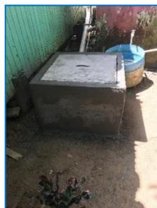
Trabajos de excavación, conformación e instalación de tuberías para conexión de sanitarios, duchas, lavamanos, lavaplatos, lavadora y construcción de caja de registro.
