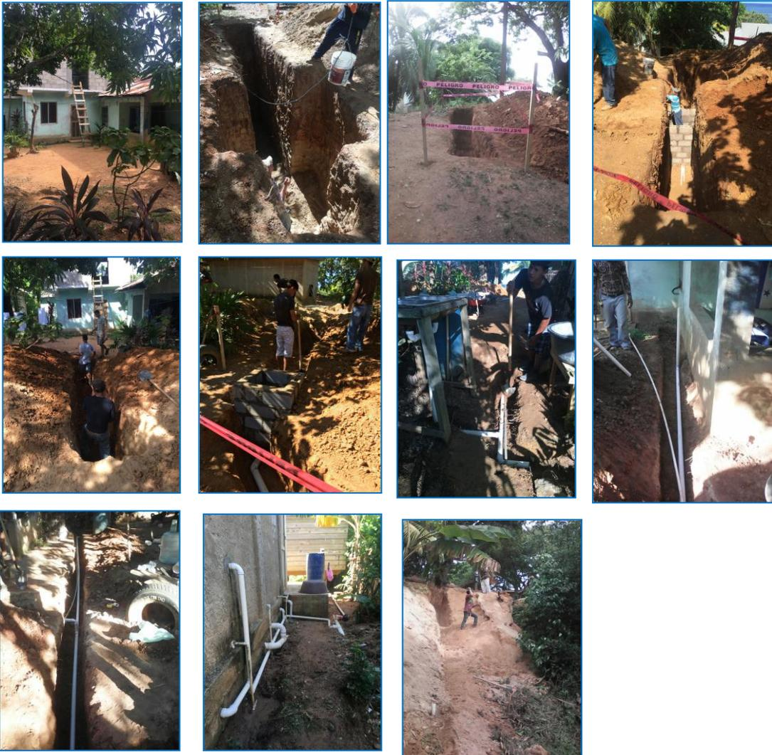
Excavación de terreno, construcción de caja principal para coleccionar las aguas residuales de la propiedad 128, 128<sup>a</sup>-E.
