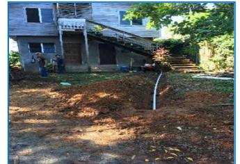
Trabajos de excavación, conformación e instalación de tuberías para conexión de sanitarios, duchas, lavamanos, lavaplatos y construcción de caja de registro
