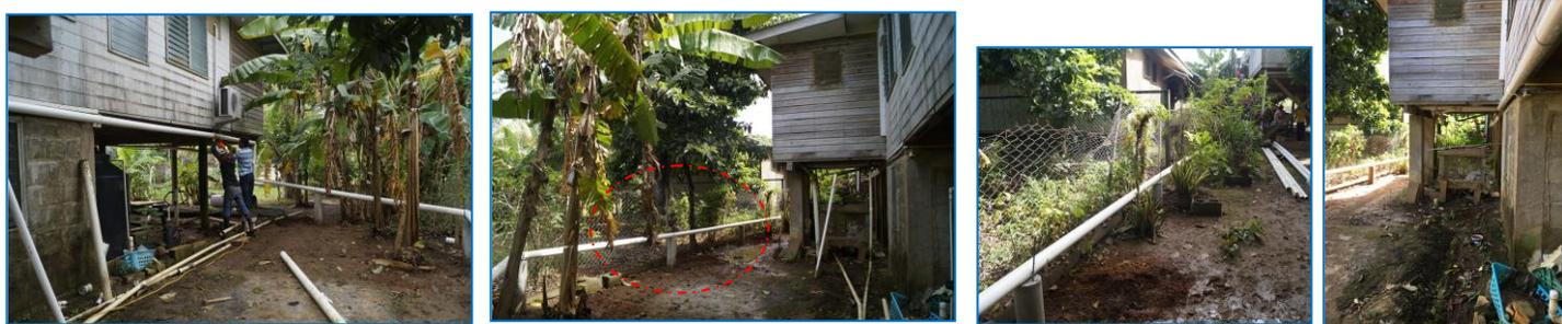
Después: Instalación de tubería sobre postes de concreto y bajo el piso de madera de la casa fijado con abrazaderas plásticas y cinta metálica.
