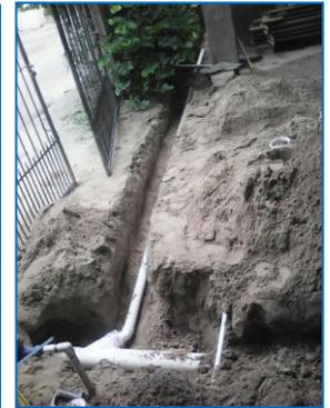
Trabajos de excavación, conformación e instalación de tuberías para conexión de sanitarios, duchas, lavamanos, lavaplatos y lavadora.
