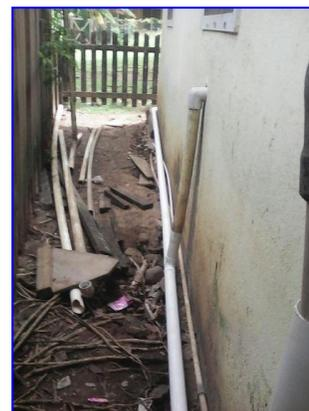
Excavación de terreno, instalación de tubería de PVC 4" línea principal y instalación de tubería PVC 2" para instalaciones de lavadora, ducha y lavamanos y lavaplatos
